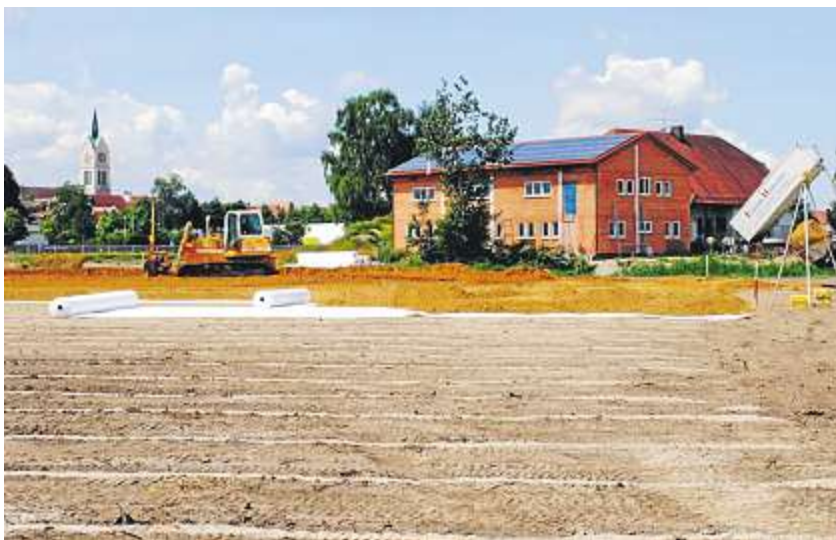
Auch mit dem Bau der neuen Sportplätze wurde jetzt begonnen.
